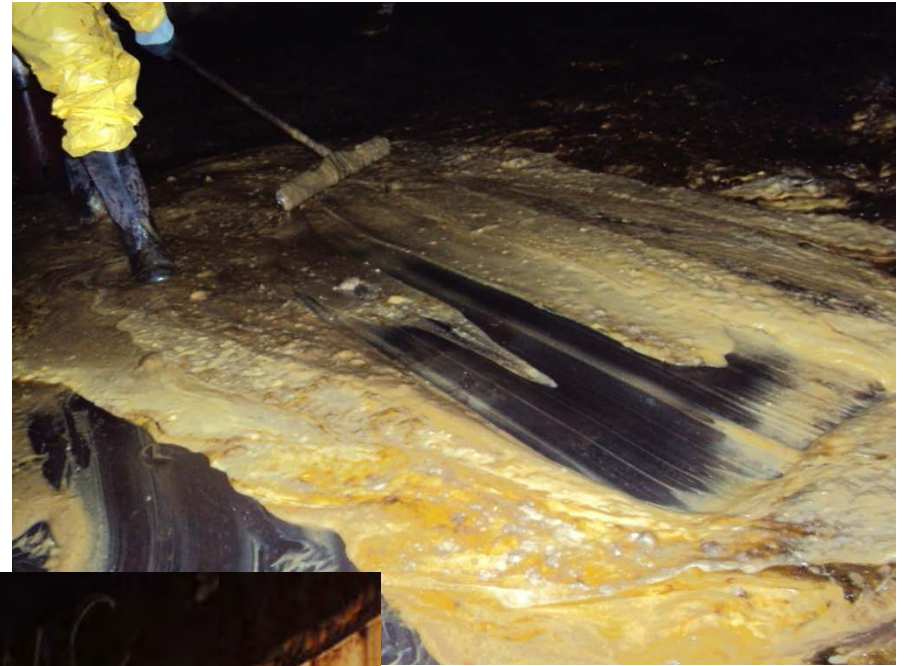
Tanque de B100 de Distribuidora – Limpeza Maio 2010
